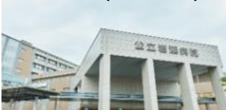
公立岩瀬病院(福島県須賀川市)
